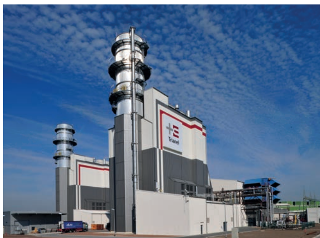
Trianel Gas- und Dampfturbinenkraftwerk Hamm | Foto: © Trianel GmbH
