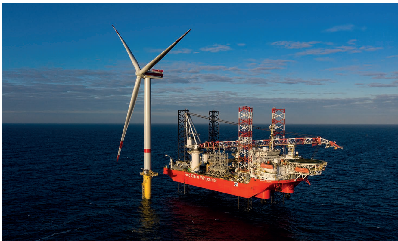
Die Bauarbeiten im Windpark TBW II sind erfolgreich abgeschlossen | Foto: © TWB II / Matthias Ibeler
