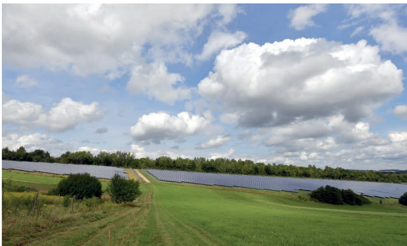
Der TEE Solarpark Südwestpfalz in Rheinland-Pfalz entlang der Autobahn A8 und A62, etwa 10 km von Pirmasens entfernt | Foto: © Trianel GmbH
